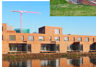
(Bouw van het) Sluiseiland
