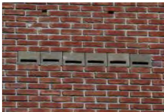
Voorbeeld van entreesteen om vleermuizen toegang te geven tot een spouwmuur
