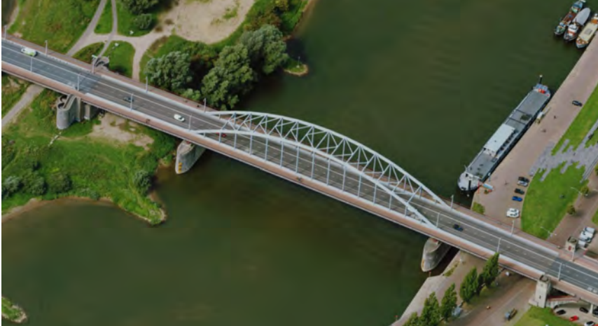
Boogbrug in situatie, 2024 (Streetsmart)
