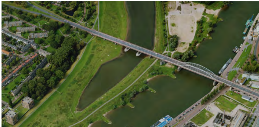
Boogbrug met aanbruggen in situatie (Streetsmart)
