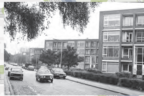
3. Diagonaal geplaatste flats als typisch wederopbouwensemble (Gelders Archief)
