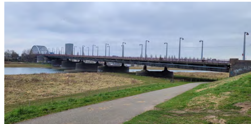
Boogbrug met aanbrug. De boogbrug vormt slecht een klein gedeelte van het geheel.
